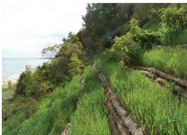
Fig. 5.29. Sistemul de control al versanților
