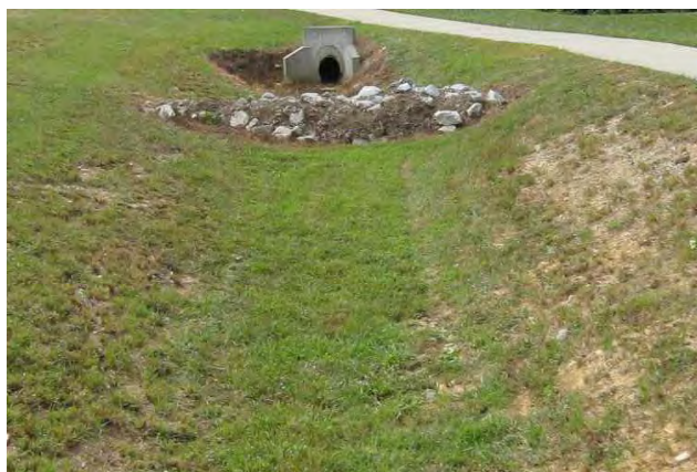
Fig. 5.3. Gură de scurgere și un zăgaz din pietre la un canal înierbat
