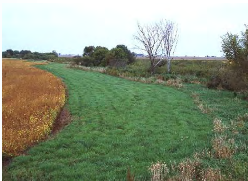
Fig. 1.8. Măsuri de atenuare a eroziunii
