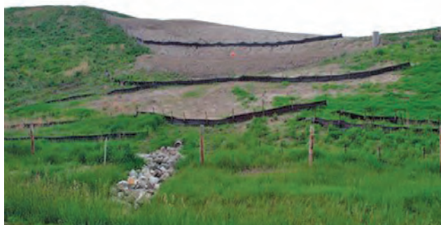
Fig. 5.27. Stabilizarea suprafețelor degradate
